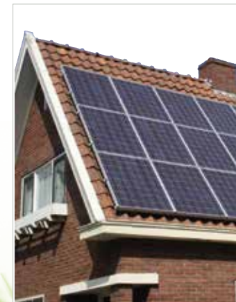
Zonnepanelen/ Capteurs solaires
